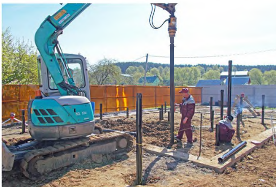
Рис.1. Погружение винтовых свай с помощью гидровращателя на базе экскаватора.
