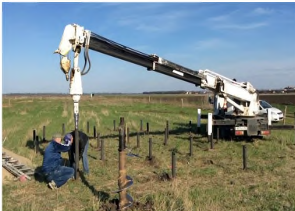
Рис.2. Погружение винтовых свай с помощью гидровращателя на базе крана-манипулятора.
